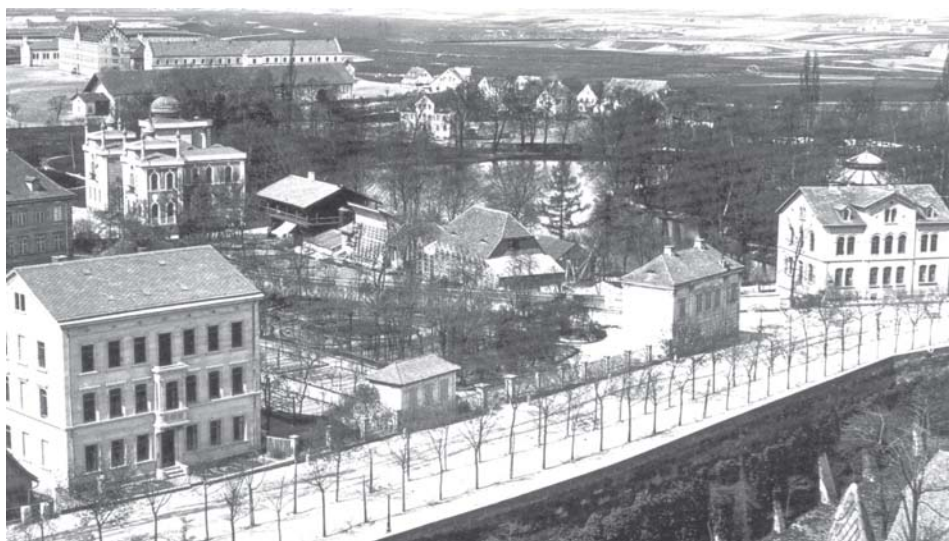
Blick vom Spittlertorturm auf die Rosenau. In der Mitte ist der Weiher zu sehen, der damals noch seine alte Größe hatte. Am rechten Bildrand hinter dem Haus, das sich an der Abzweigung der Dennerstraße vom Spittlertorgraben befand, ist die Insel im Weiher zu erkennen. Links die Alhambra und dahinter die Gebäude der Bärenschanzkaserne, die bis zur Bleichstraße und Himpfelshofstraße reichten
