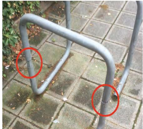
**Bild 1: OBACHT !: Unsichere Fahrrad-Ständer mit Schnellklauvorrichtung**
